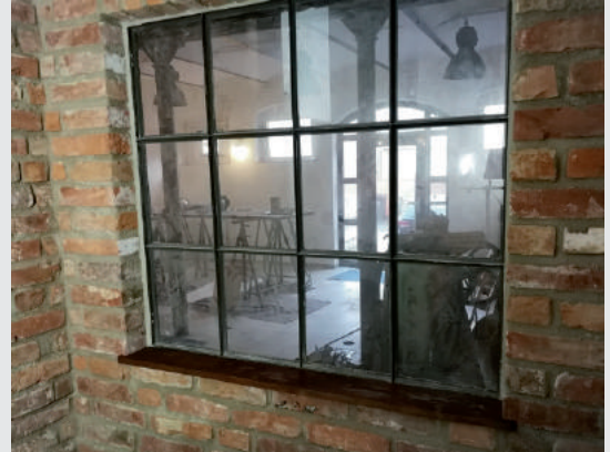
Eines der alten Fabrikfenster in den Räumlichkeiten
